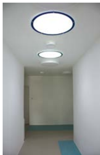
Ve vnitřní chodbě bez oken jsou světlovody hlavním zdrojem osvětlení.
