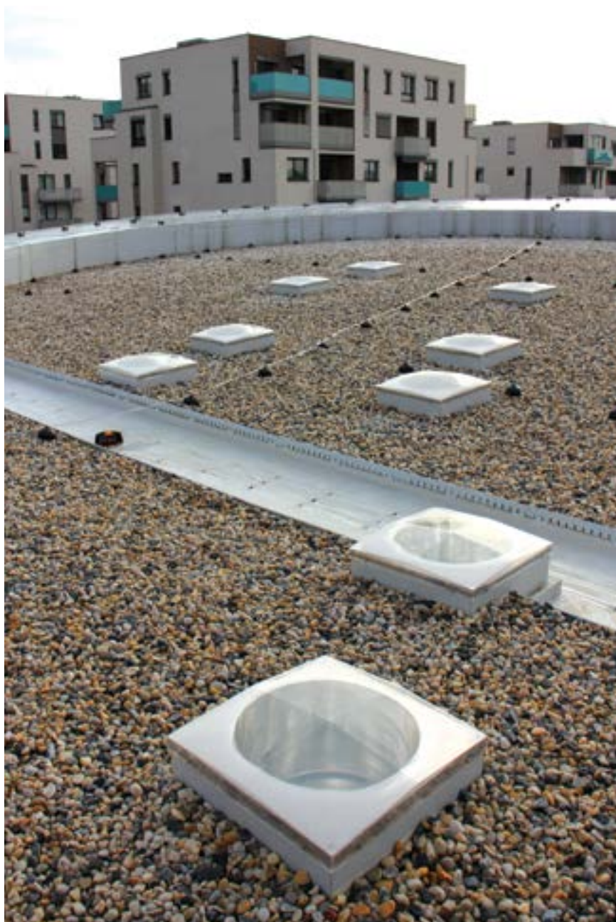
Pro přerušení tepelného mostu se v konstrukci střechy instalovala tepelněizolační skla, aby se zabránilo únikům tepla.
